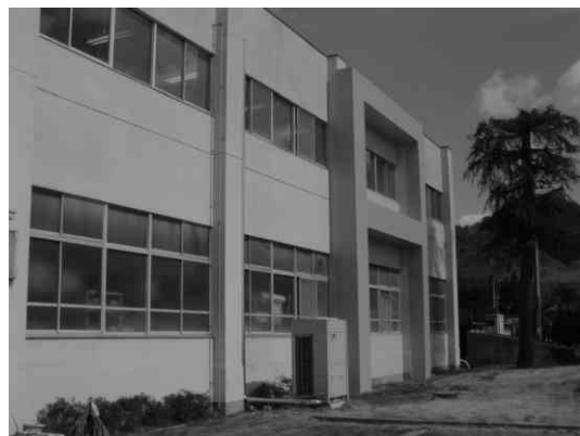
写真4 補強後 (西松建設提供)
