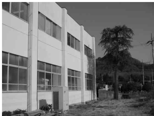
写真3 補強前 (西松建設提供)
