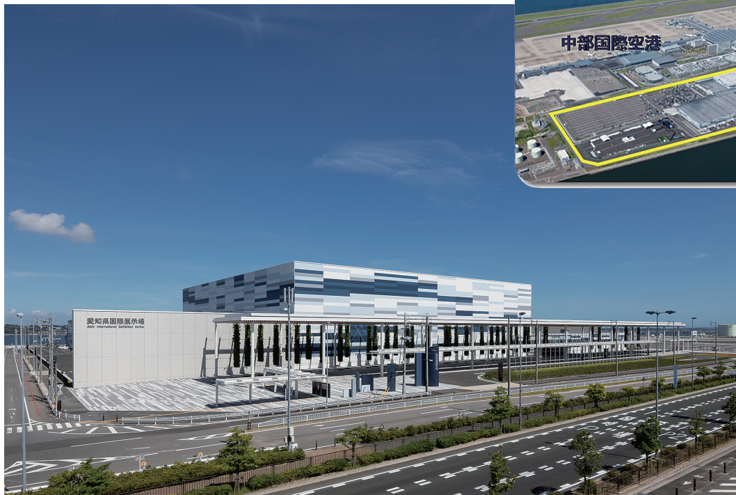
写真1 北西から見た建物外観及び上空から見た建設地
