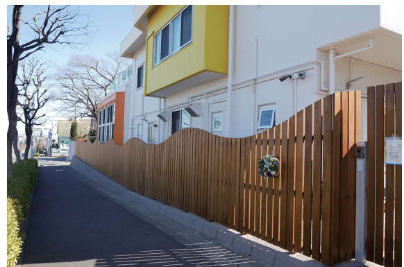
写真10 保育園に設置した木塀
