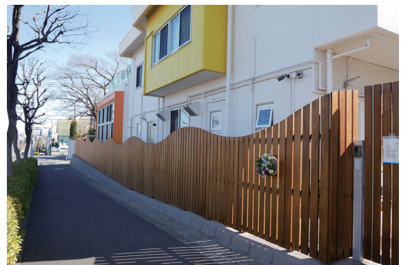
写真10 保育園に設置した木塀
