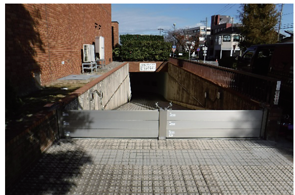
写真1 水防設備（止水板）の設置事例（左：東雲地方合同庁舎（東京都）、右：金沢新神田地方合同庁舎（石川県））
