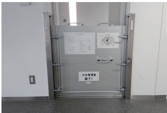
写真1 水防設備（止水板）の設置事例（左：東雲地方合同庁舎（東京都）、右：金沢新神田地方合同庁舎（石川県））
