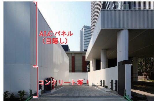
写真5 電気設備周囲の塀（外観）
