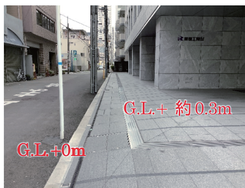
写真3 建物1階床面の嵩上げ(a)
