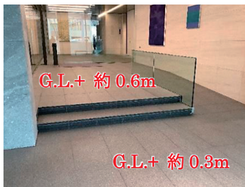
写真4 建物1階床面の嵩上げ(b)
