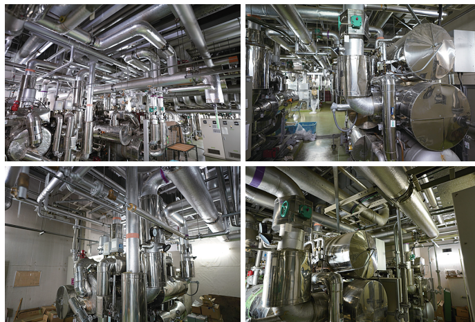
図1 工事対象エリアのデジカメ画像
