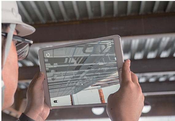
写真7 AR（拡張現実）を用いた新たな現場確認手法
