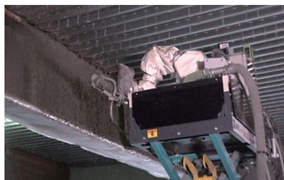
写真2 耐火被覆吹付ロボット
