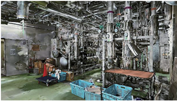
図2 写真測量技術を用いた3Dモデル
