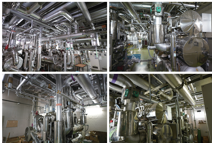
図1 工事対象エリアのデジカメ画像
