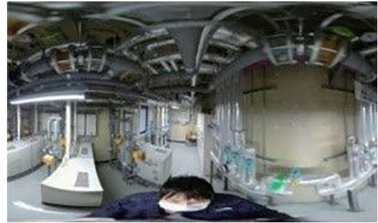
図4 取得した全方位カメラ撮影動画の一部
