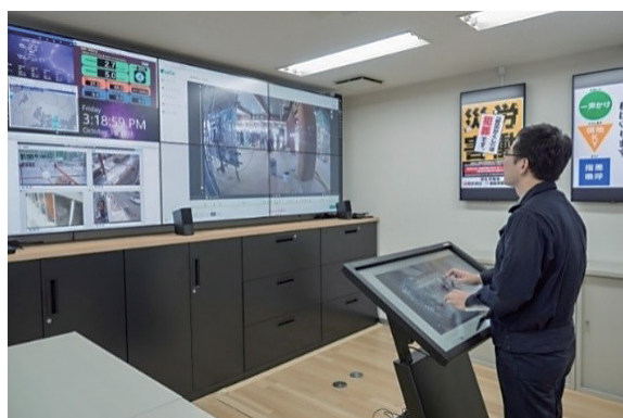
写真6 施工管理情報を一元表示するスマート工事事務所
