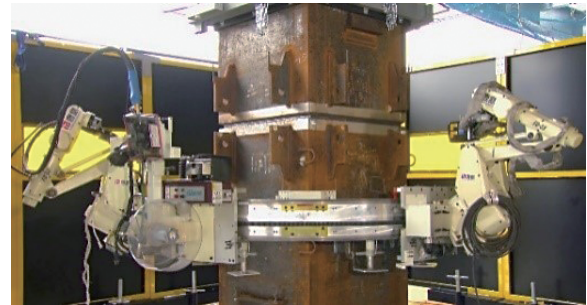
写真4 マニピュレータ型溶接ロボット
